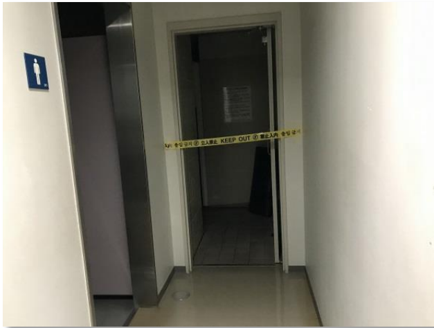
▼更衣室内シャワールーム立入禁止
